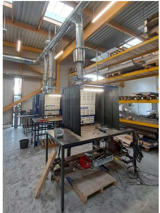
Réseau basse dépression avec dossier aspirants.
