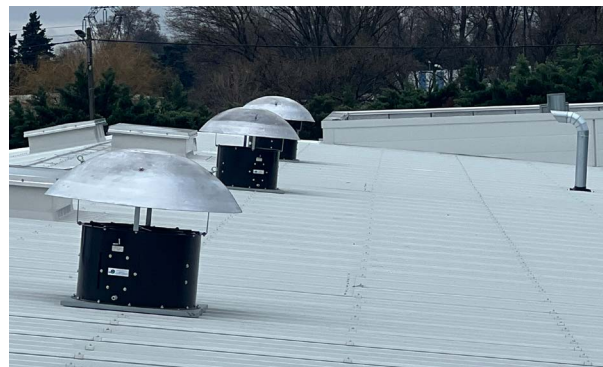
Tourelles avec clapets anti-retour
