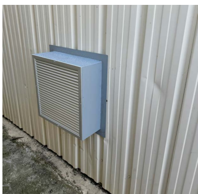
Soufflage par volets gravitaires
