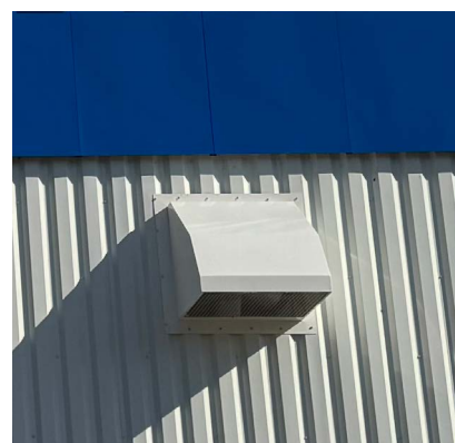
Caissons de finition
