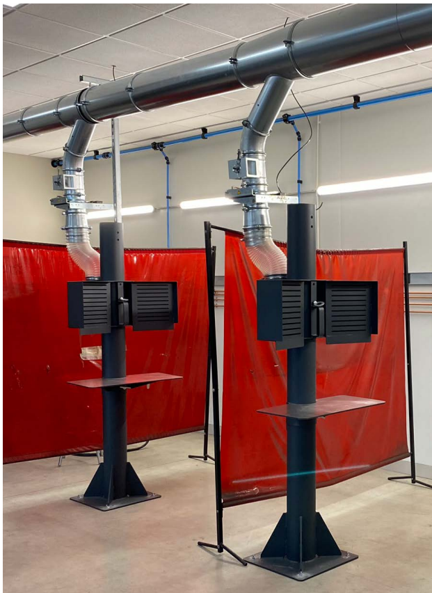
Réseau basse dépression avec mâts aspirants.
