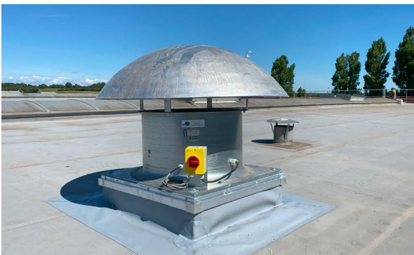
Tourelle standard avec arrêt d'urgence
